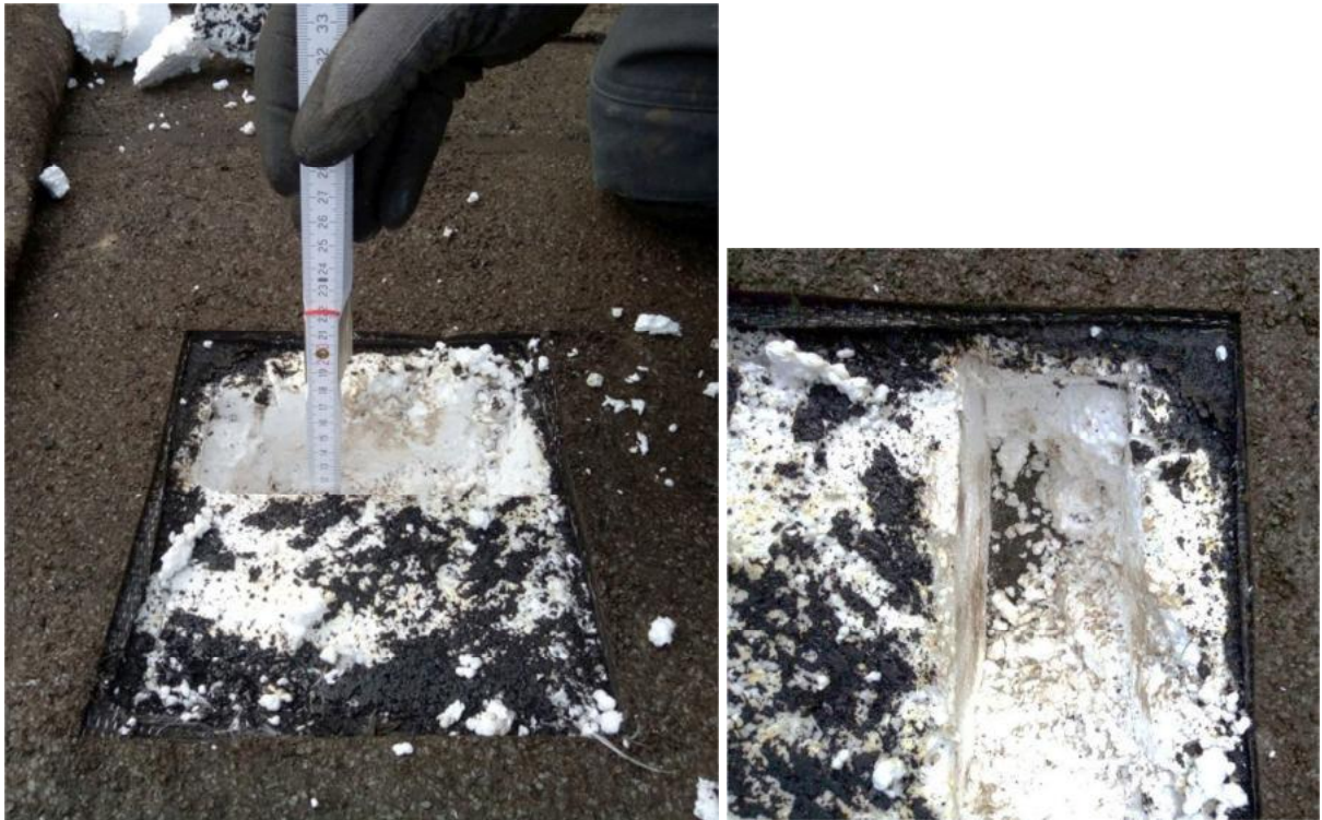
Foto 11: Dachaufbau Altbau Hauptgebäude über dem EG: doppelagige Bitumenabdichtung (nicht asbesthaltig; Probe „Dach Altbau 1“ und „Dach Altbau 2“), Styropordämmung (HBCD-haltig, Mischprobe MP2), unterste Bitumenabdichtung (nicht geöffnet)
