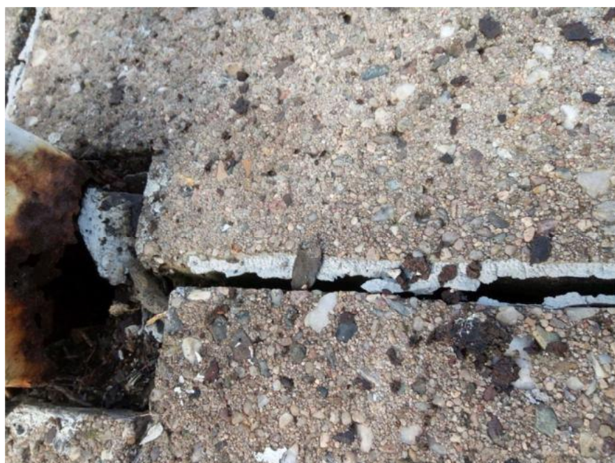
Foto 4: Überreste von dauerelastischem Fugenmaterial auch zwischen den Treppenaufgängen Außenbereich (Fugenmasse Treppenaufgang Probe EP5)
