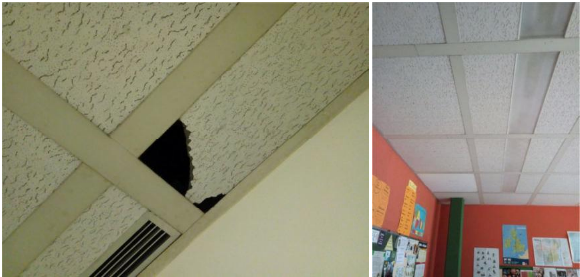
Foto 23: Akustikdeckenplatten aus KMF-Pressplatten, kein Asbest nachgewiesen (Probe EP24)
