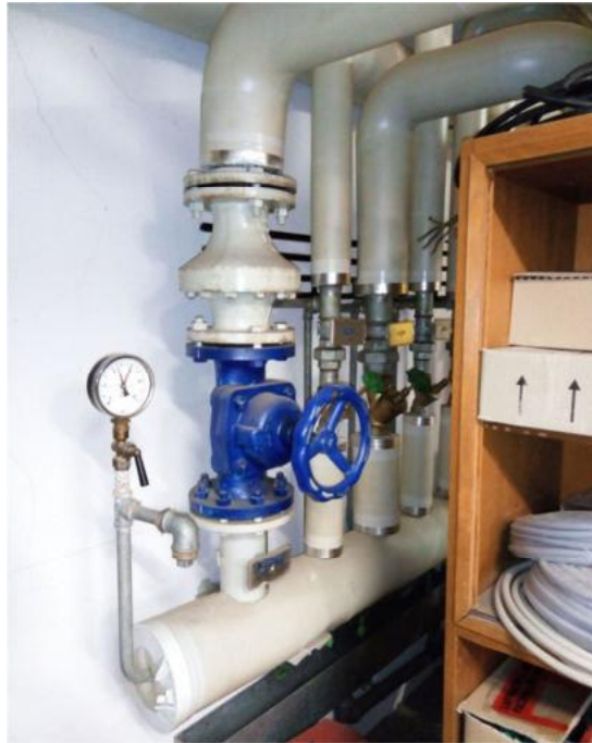
Foto 21: Werkstatt neben Lüftungsanlage: Flanschdichtungen mit Asbestverdacht, Rohrisolierung mit KMF Kategorie 1B
