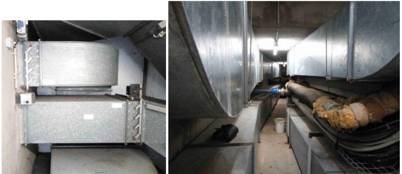
Foto 15: Blechkanäle der Lüftungsanlage und Rohrisolierung im Raum Haustechnik neben der Werkstatt sowie im Versorgungsschacht; Flanschdichtungen Blechkanäle und Rohrleitungen mit Asbestverdacht, KMF Kategorie 1B (Probe EP22)
