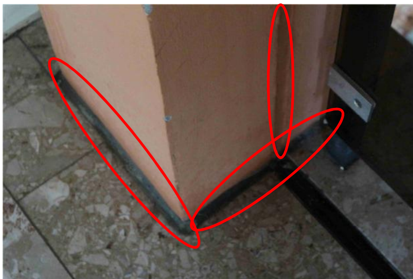
Foto 2: PCB-freie dauerelastische Fugenmassen im Innenbereich; Aufgrund stark erhöhter EOX-Gehalte beim Ausbau sauber von mineralischen Abfällen trennen
