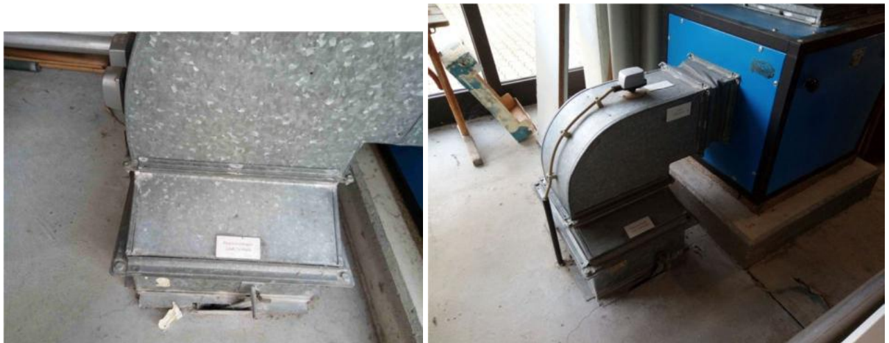
Foto 20: mehrere Feuerschutzklappen mit asbesthaltigen Bauteilen (schwach gebunden), hier exemplarisch Zuluft Turnhalle (linkes Bild) und Zuluft Nebenräume Hauptgebäude (rechtes Bild)
