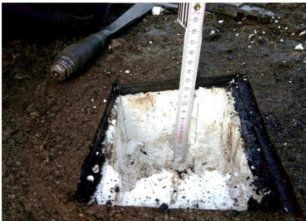
Foto 12: Dachaufbau über dem OG Hauptgebäude neuer Anbau, Styropor HBCD-haltig (Probe MP2). Das Dach des der Fahrradunterstandes ist ungedämmt.
