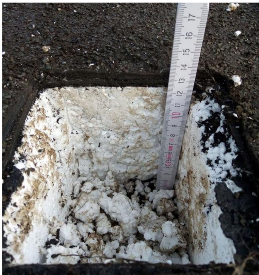
Foto 10: Dachaufbau Turnhalle: doppelagige Bitumenabdichtung, Styropordämmung (HBCD-haltig), unterste Bitumenabdichtung (nicht geöffnet)
