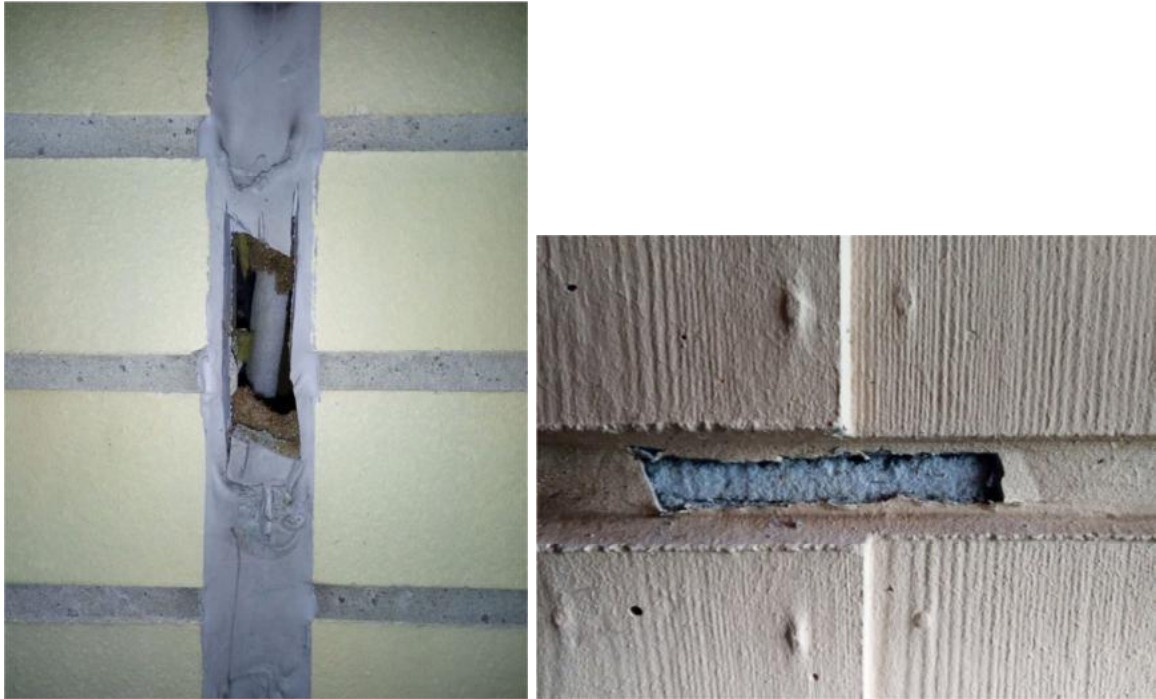
Foto 4: Überreste von dauerelastischem Fugenmaterial auch zwischen den Treppenaufgängen Außenbereich (Fugenmasse Treppenaufgang Probe EP5)
