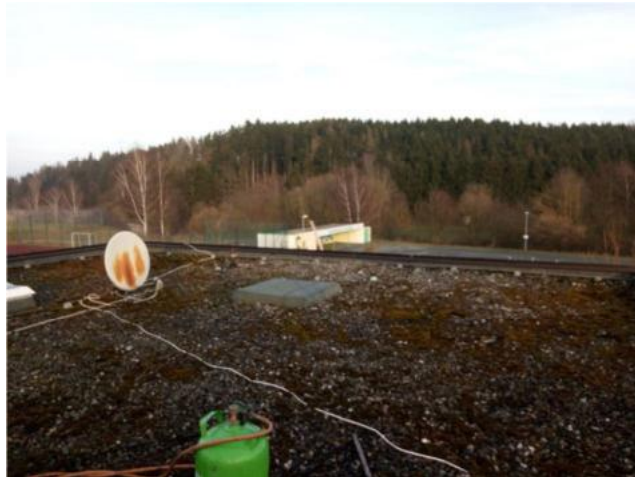
Foto 14: Aufbau Dämmung und Abdichtung Schulterterrasse, Dämmung: Styrodur, aufliegende Bitumenbahn ist Gewebeverstärkt (Glasfaser)
