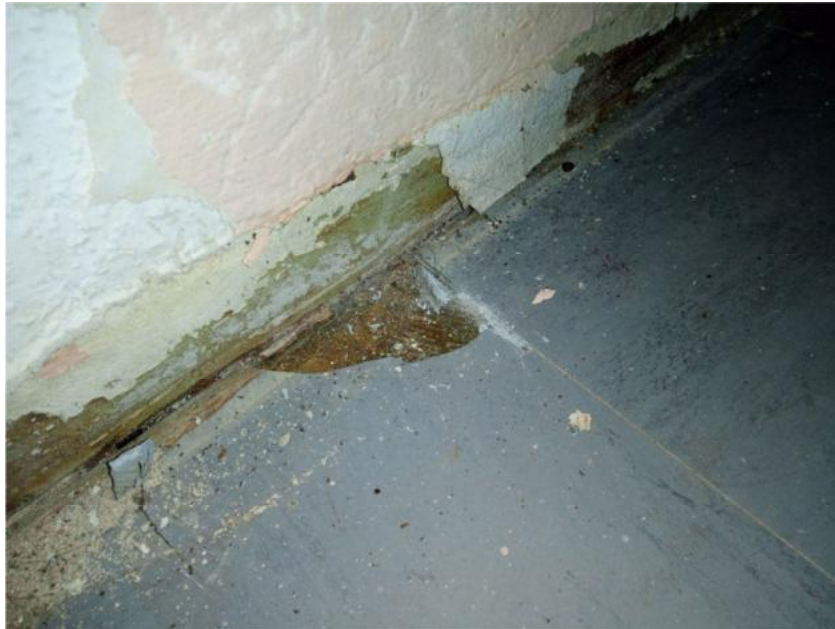
Foto 25: asbesthaltige Floorflexplatten im KG Hausmeistergebäude, Kleber nicht asbesthaltig (Probe EP16)
