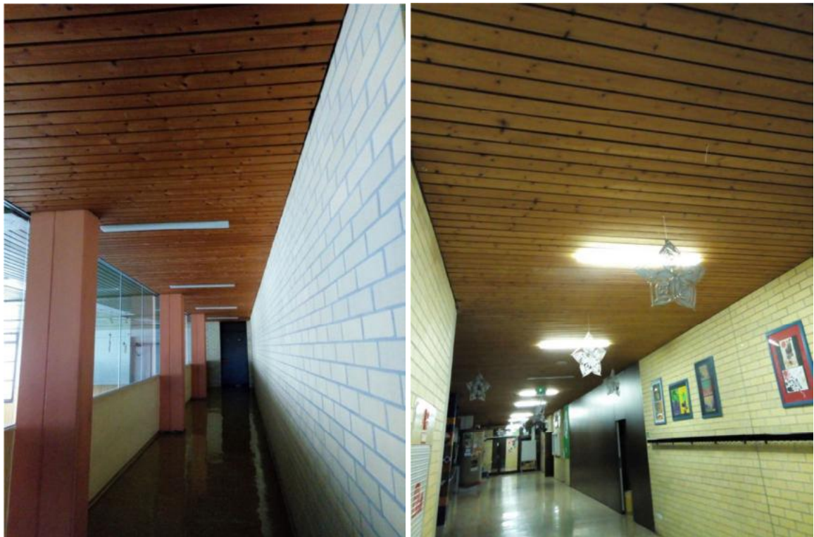
Foto 22: Holzuntersicht im gesamten Schulhaus mit aufliegender vlieskaschierter KMF der Kategorie 1B (Probe EP21). Holzuntersicht ist All-Holz (Probe MP3)
