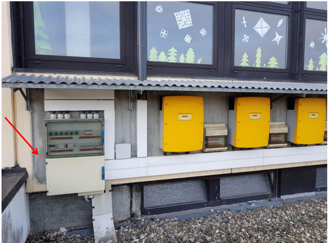
Foto 8: asbestfreie Faserzementplatte (Probe EP18) hinter Elektronik der PV-Anlage
