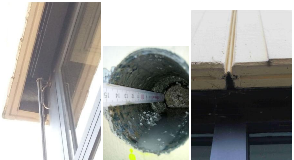
Foto 24: Detailansichten Sandwichelemente Gebäudehülle Hauptgebäude aus Betonelementen und Styropordämmung
