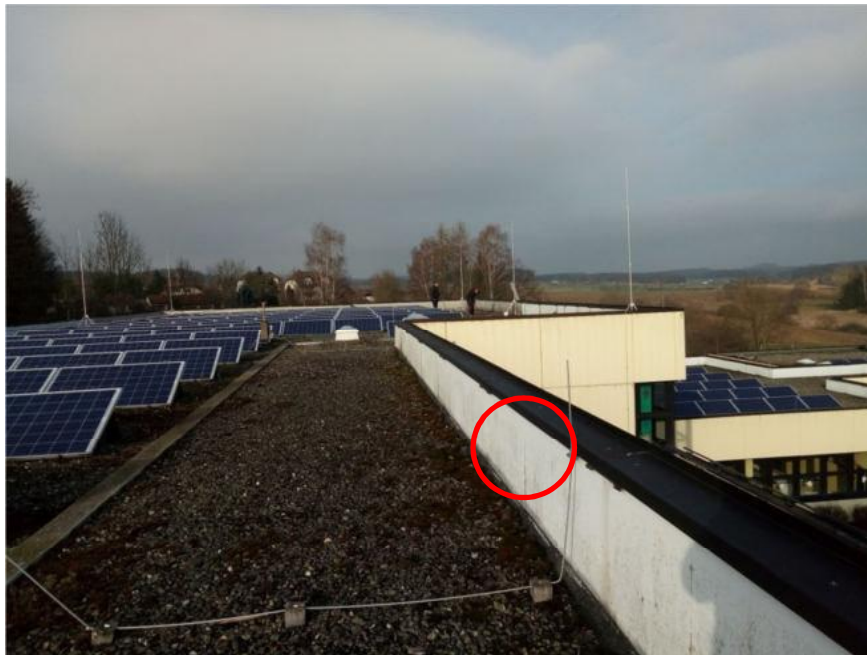
Foto 9: Verkleidung der Attika mit Asbestzementplatten (Probe EP17)
