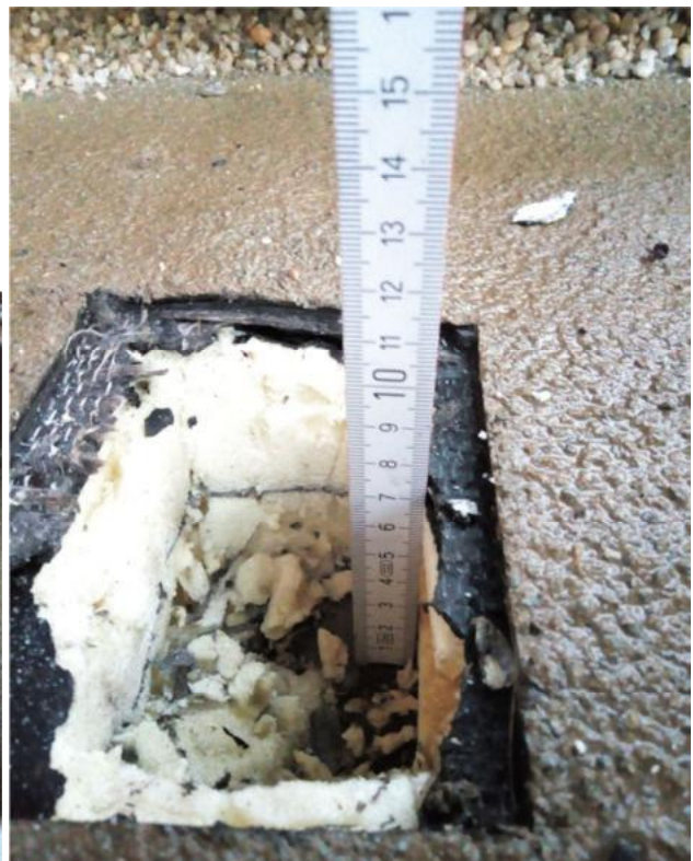
Foto 14: Aufbau Dämmung und Abdichtung Schulterterrasse, Dämmung: Styrodur, aufliegende Bitumenbahn ist Gewebeverstärkt (Glasfaser)
