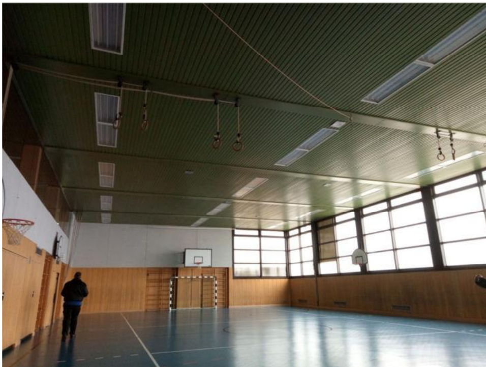
Foto 26: Deckenuntersicht Turnhalle, Sanierungsbegleitend hinsichtl. Holzschutzmittel untersuchen
