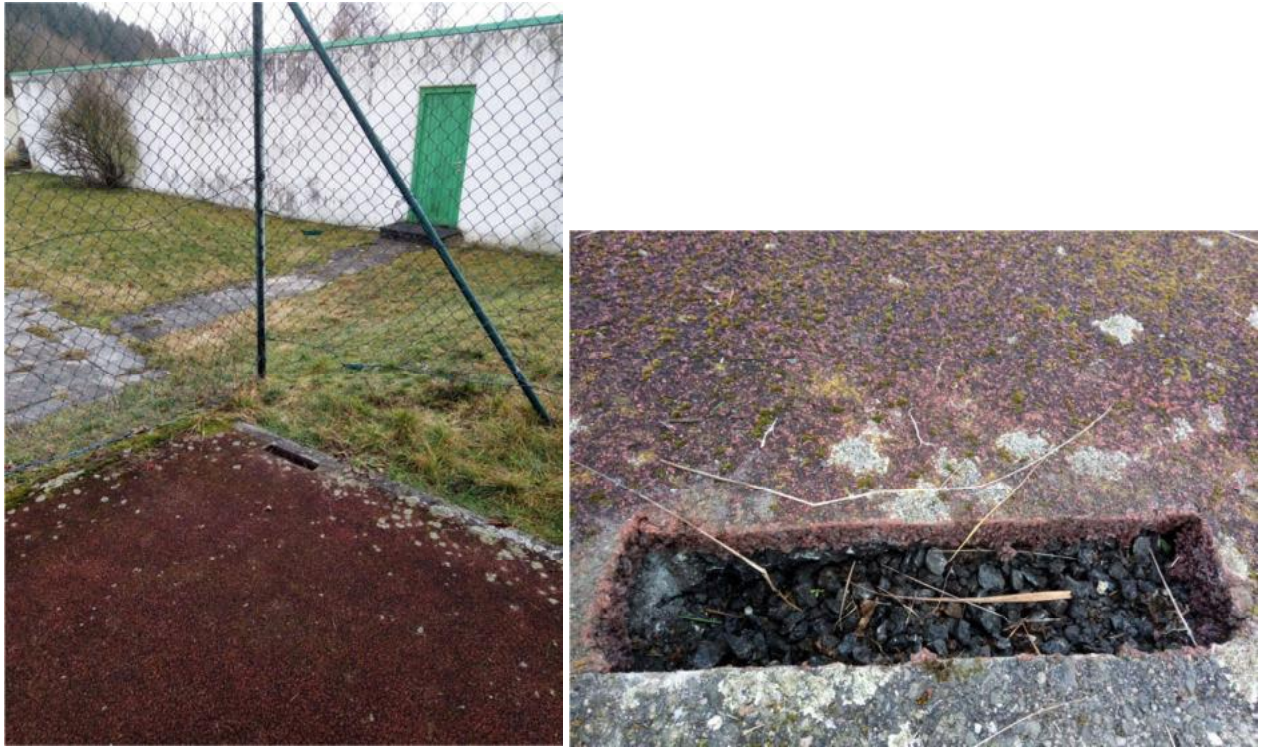
Foto 5: Probenahmestelle roter Kunststoffoberbelag (2 cm stark, Probe EP1) Hartplatz mit Unterbau aus feinem Schotter / Splitt (Probe EP2)
