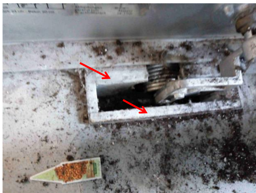
Foto 18: Detailansicht: auch Gehäusedämmung der Brandschutzklappen (hier Bodenbereich) mit leichter mineralischer Platte, schwach gebundenen Asbest enthaltend
