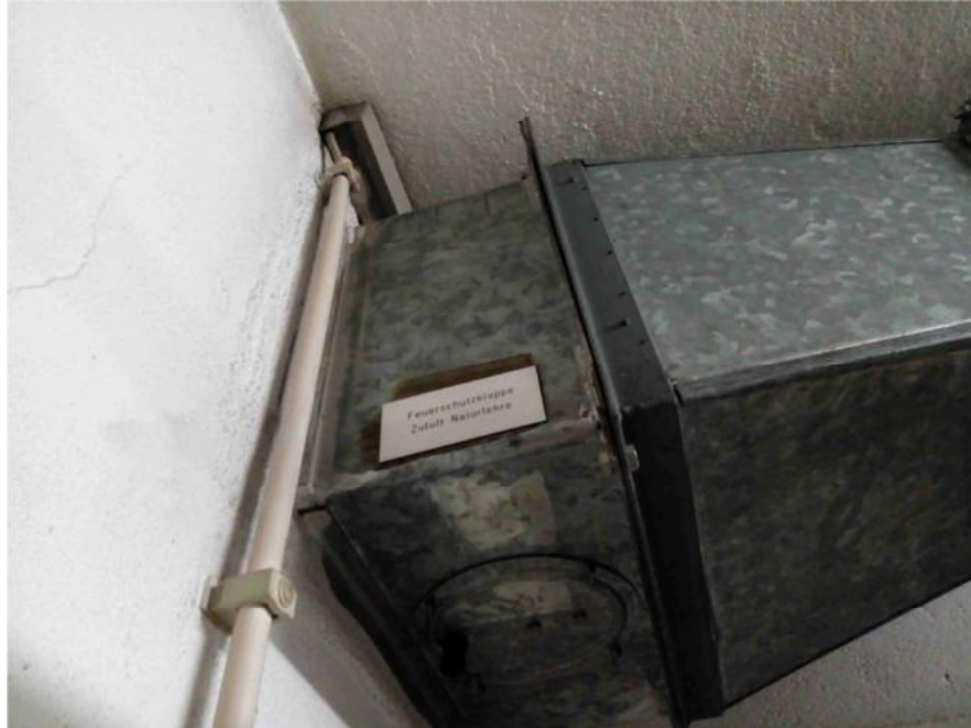
Foto 19: Weitere Feuerschutzklappe vergleichbarer Bauart (hier Zuluft Naturlehre), Feuerschutzmörtel um Brandschutzklappe ist nicht asbesthaltig (Probe EP15)
